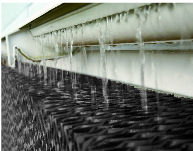
Распределение воды в охладителе с рамой ПВХ
